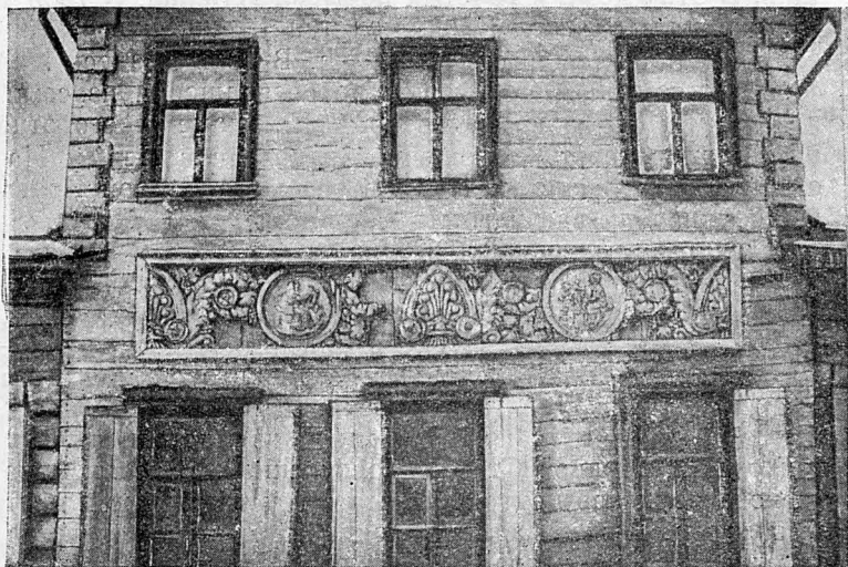
Фрагмент фасада деревянного дома по М. Власьевскому пер., № 5 Первая половина XIX в. Музей Академии архитектуры. Москва
