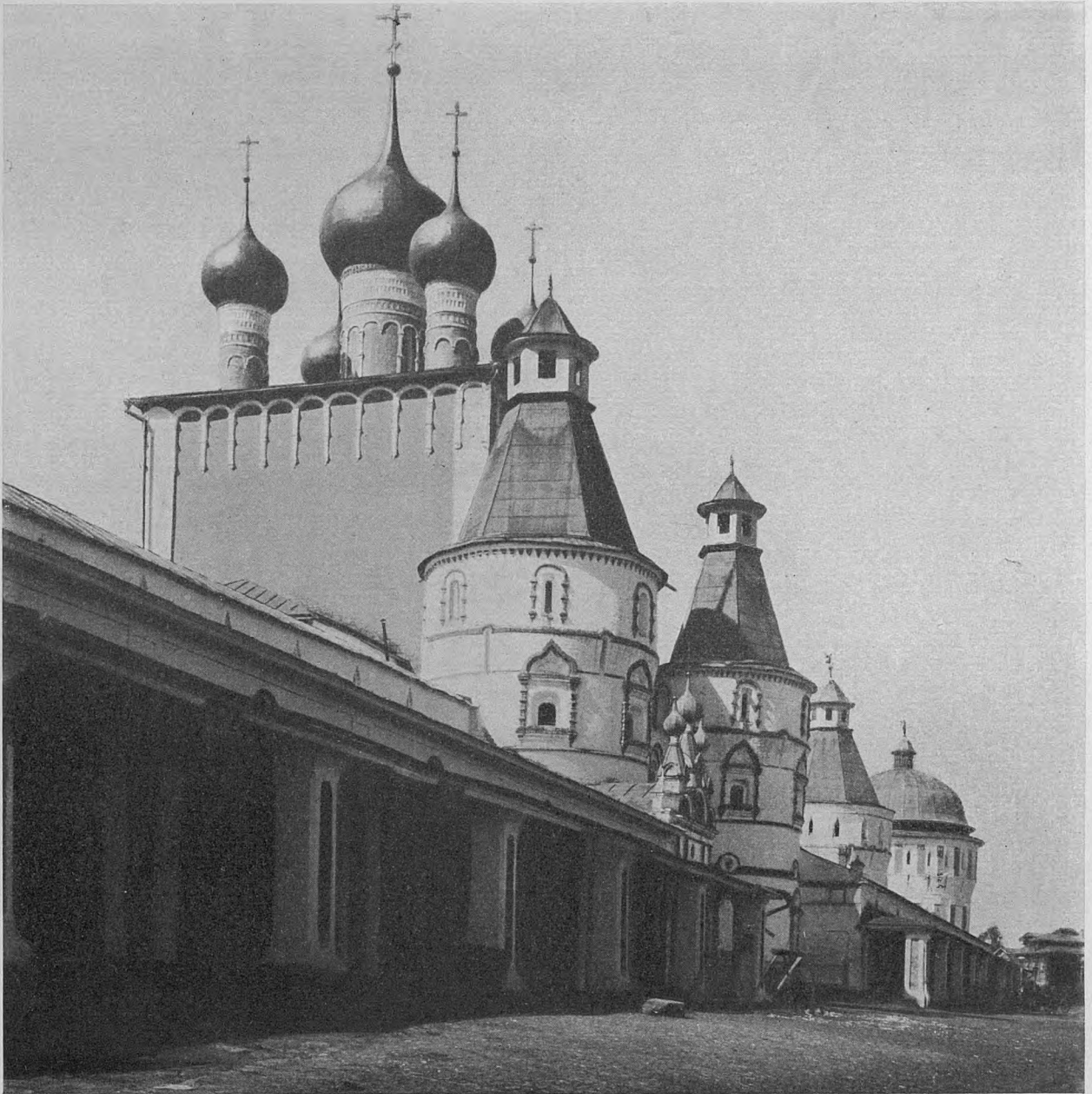
Церковь Срѣтенія и башни сѣверной стѣны.—17-й вѣкъ.
