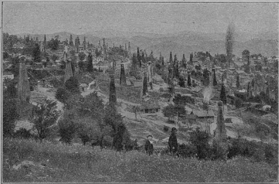
Добыча нефти въ Румыніи. Нефтяныя вышки, построенныя надъ буровыми скважинами. Вдали нефтяной фонтанъ.
