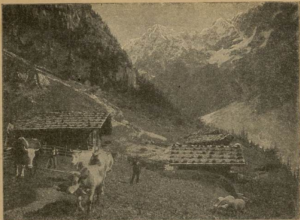
Горныя хижины (шале). Камни на крышах наложены съ тою цѣлью, чтобы сдѣлать ихъ болѣе стойкими при сильныхъ горныхъ вѣтрахъ.
