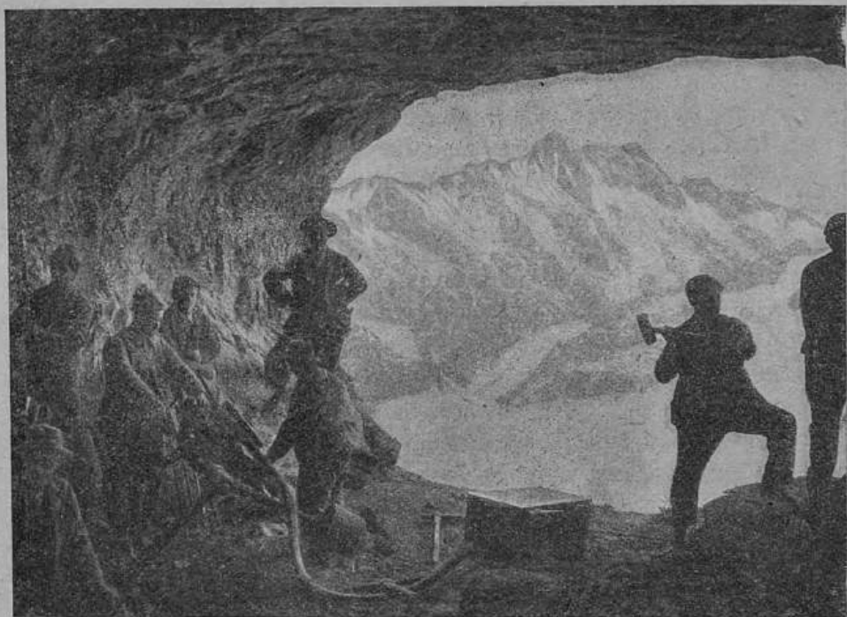
Прокладка туннеля для зубчатой желѣзной дороги на Юнгфрау. Рабочіе посредствомъ электрическаго бурава сверлятъ отверстія для закладки динамита и взрыва каменныхъ массъ. Изъ туннеля открывается видъ на Бераскія Альпы.
