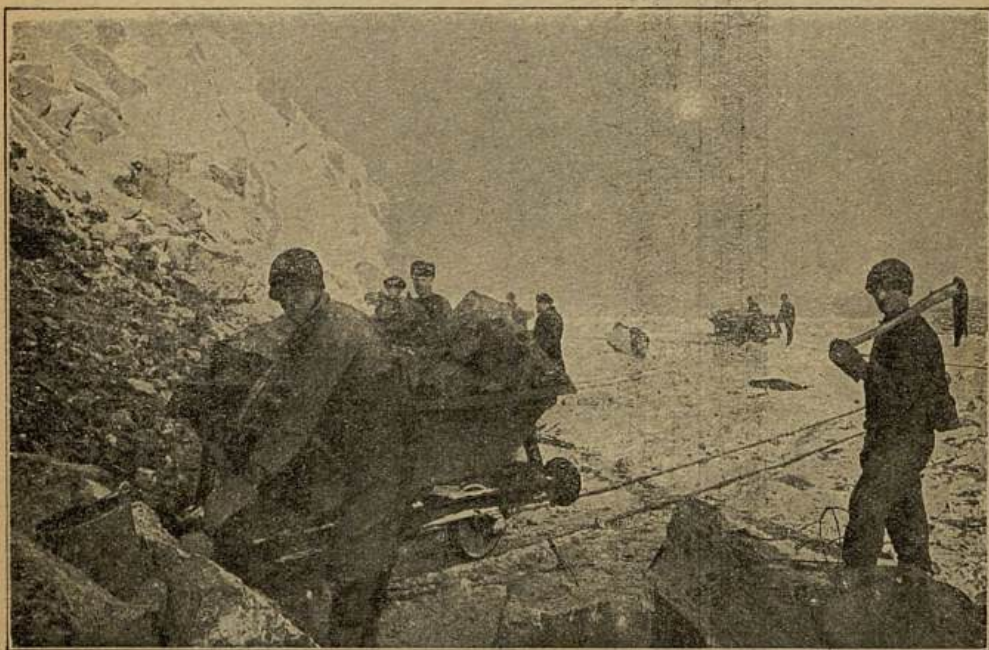
Добыча руды въ Кирунѣ. Въ массѣ магнитнаго желѣзняка рудокопъ выбиваетъ отверстіе, чтобы заложить туда динамитъ. Направо уже оторванные отъ горы динамитомъ большіе куски руды; чтобы разорвать ихъ на болѣе мелкія части, въ нихъ сдѣланы отверстія, заложены динамитъ и вставлены зажигающіе шнуры. Добытая такимъ способомъ руда грузится въ вагончики и спускается къ подножію горы.
