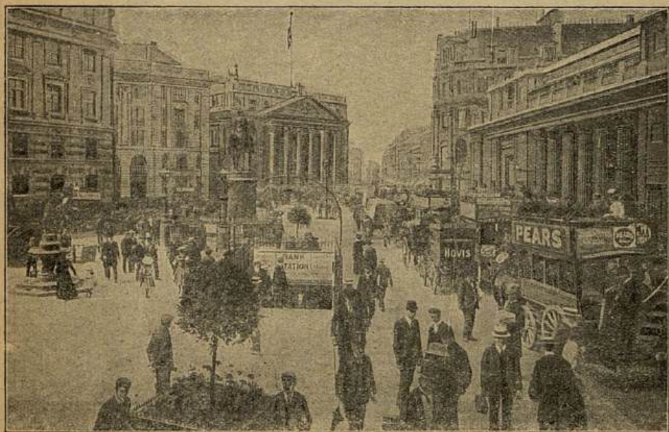
Главная площадь Сити, у Англійскаго банка (неввысокое зданіе съ колоннами направо). Пло- щадь эта служить крышей для подземнаго вокзала, куда ведетъ спускъ съ надписью «BANK STATION».
