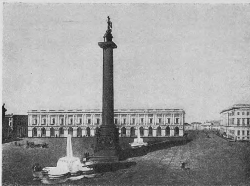
60. Дворцовая площадь и Александровская колонна
