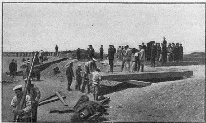
Сооруженіе батареи на сухопутномъ фронтѣ.
