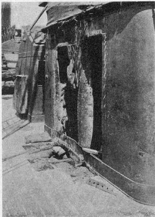
Разрушенія на крейсере „Баянъ“.
